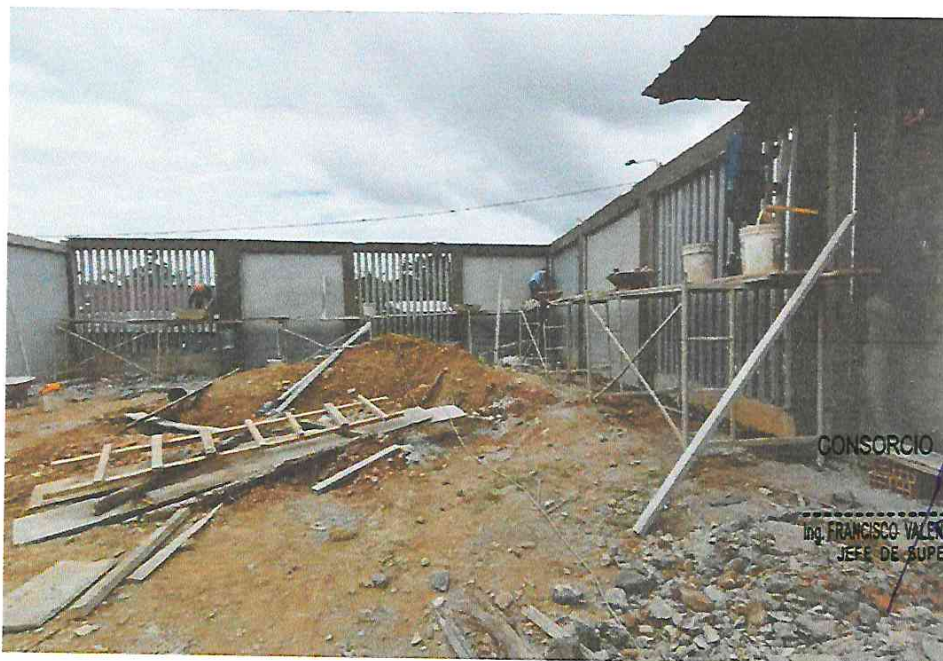
Foto N° 10: Vista del tarrajeo frotachado del cerco perimétrico en el tramo IV y V parte interior en la obra "Mejoramiento y Equipamiento del servicio Educativo N 62200 Barrio Carabanchel - San Lorenzo, Distrito Barranca, Provincia Datem Del Marañón - Loreto"
