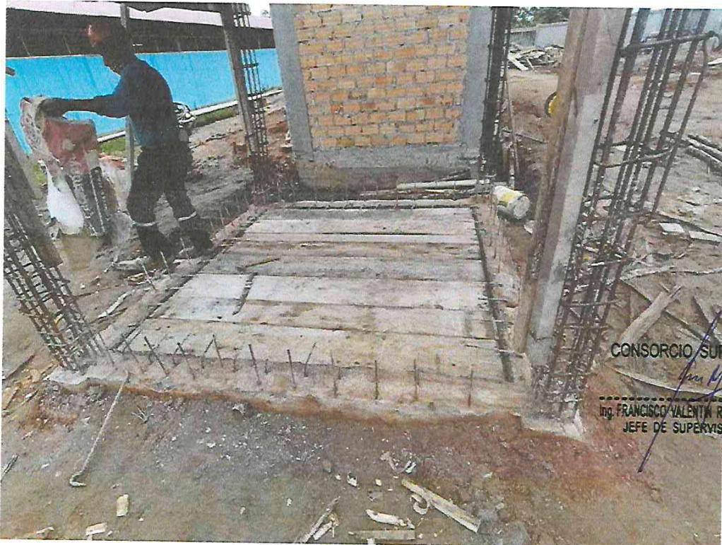
Foto N° 04: Vista del encofrado inferior del techo de cisterna en la obra "Mejoramiento y Equipamiento del servicio Educativo N 62200 Barrio Carabanchel - San Lorenzo, Distrito Barranca, Provincia Datem Del Marañón - Loreto"
