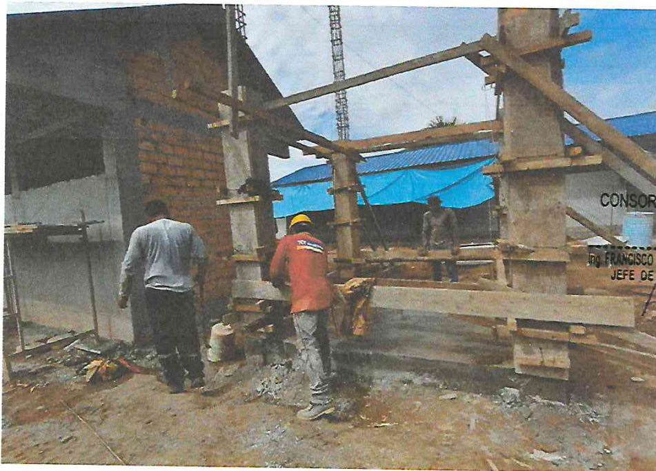
Foto N° 08: Vista de del encofrado de columnas para el tanque elevado en la obra "Mejoramiento y Equipamiento del servicio Educativo N 62200 Barrio Carabanchel - San Lorenzo, Distrito Barranca, Provincia Datem Del Marañón - Loreto".
