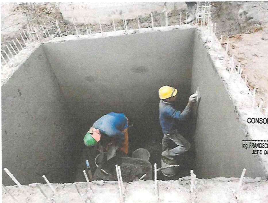
Foto N° 02: Vista de tarrajeo frotachado en muros del tanque cisterna en la obra “Mejoramiento y Equipamiento del servicio Educativo N 62200 Barrio Carabanchel - San Lorenzo, Distrito Barranca, Provincia Datem Del Marañón - Loreto”.
